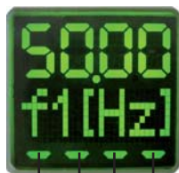
Zustand Steuereingänge B1, B2 und B3 Melderelais K3
